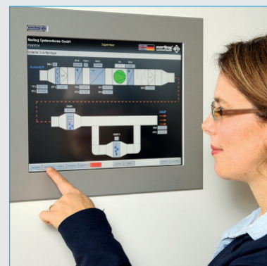
Die zentrale Raumsteuerung über Touchpanel
