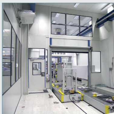
Messraum mit Fördertechnik
